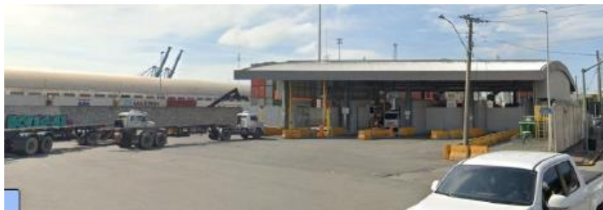
Figura 36 – Gate área pública Fonte: Consórcio Demarest
