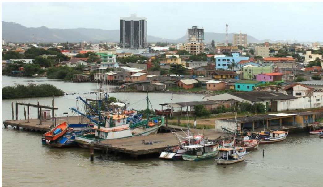
Figura 6 – Vista superestrutura a ser demolida Fonte: Consórcio Demarest
