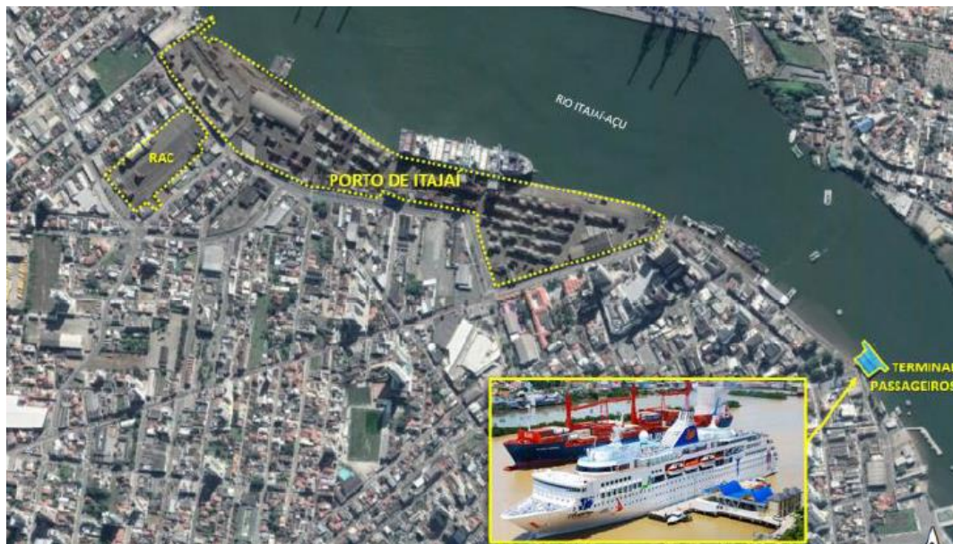
Figura 12 – Terminal de Passageiros (Itajaí) Fonte: PDZPI/2019
